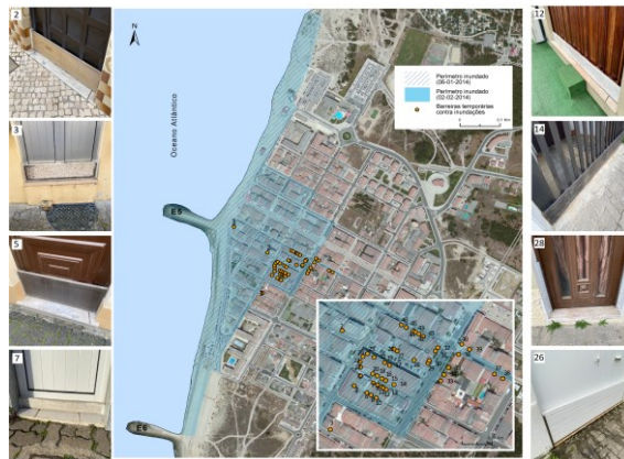
Figura 1. Localização geográfica das estruturas de adaptação, as barreiras temporárias contra inundações, face à área máxima inundada em 2014 (Adaptado de Pinto, 2022).
